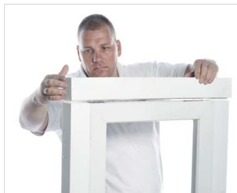
Vorfertigung des Rahmens bei der VAM-Montage („Von Außen Montiert“)
